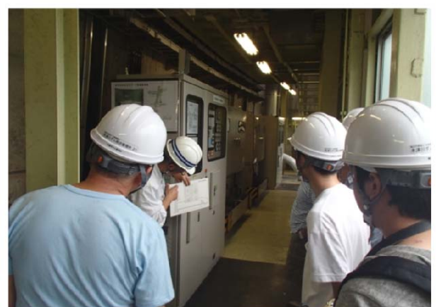
常用洪水吐きゲート機械室
